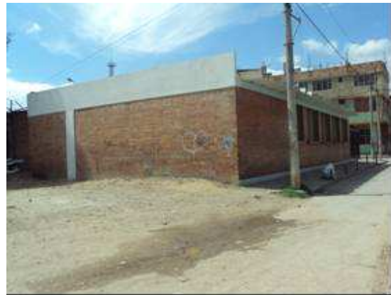
VISTA ESTRUCTURA Y CUBIERTA FACHADA POSTERIOR
