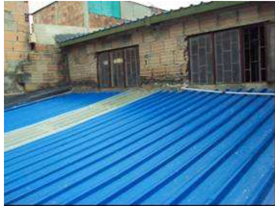
VISTA CUBIERTA TERMO ACUSTICA
