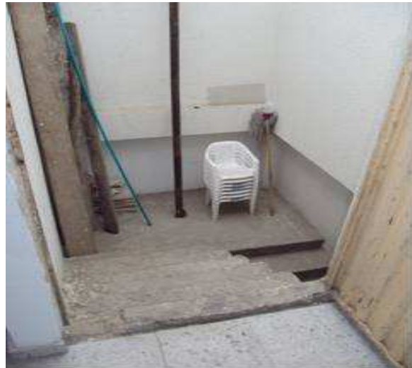
VISTA ACCESO VERTICAL (ESCALERA)
