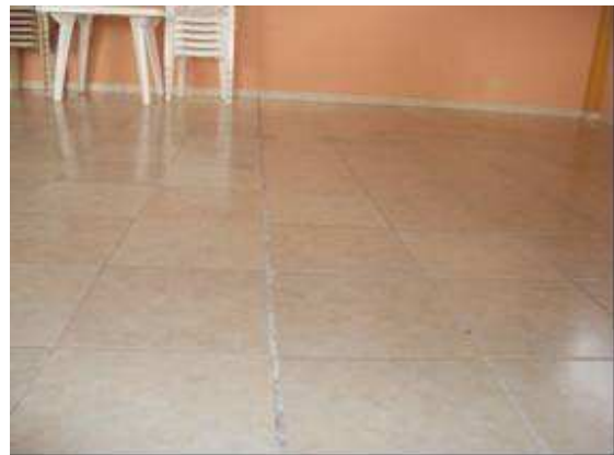
VISTA INTERIOR CARAMICA PISO SALON DE LA SEGUNDA PLANTA
